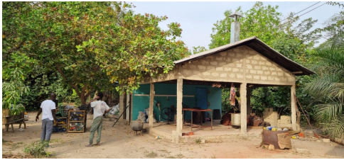
Terrein met overdekte werkplaats
